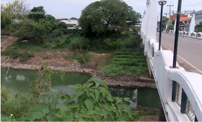
C031703 : สะพานห้วยหลวงอนุสรณ์ ต.จุมพล อ.โพธิ์ชัย จ.หนองคาย
